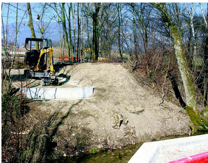
Für die Montage der neuen Brücke über den Dürnbach ist alles bereits vorgekehrt. AK
